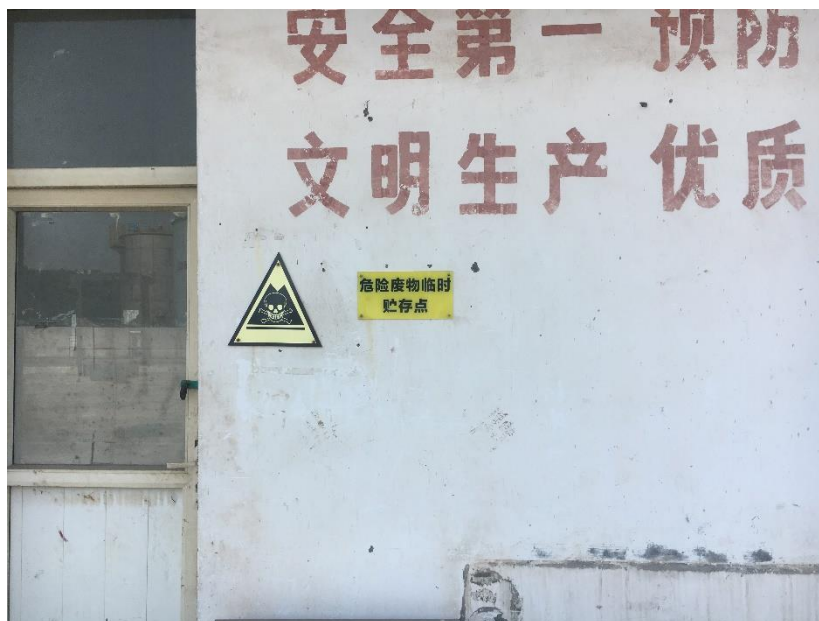
图3-6 原危废暂存间（现已关闭）
