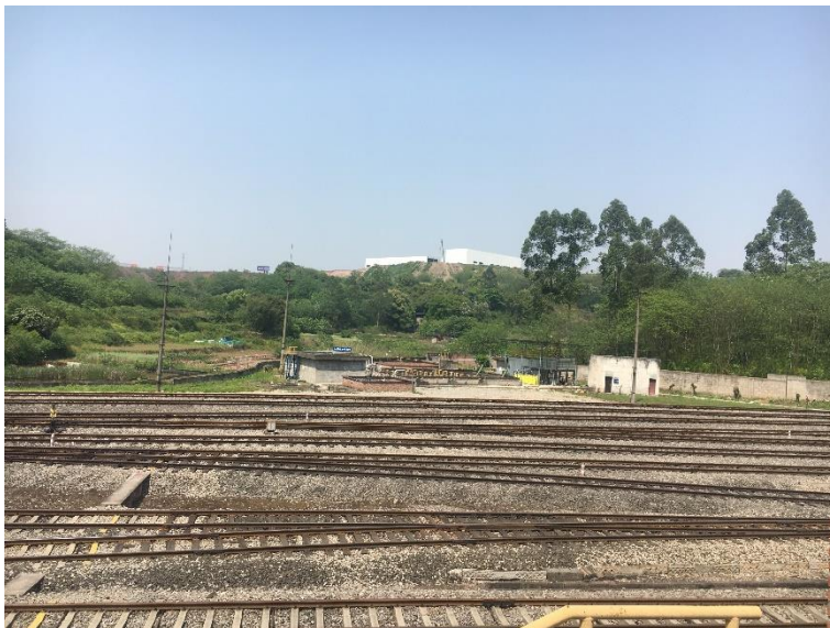
图 3-2 改造后污水处理站（全貌）
