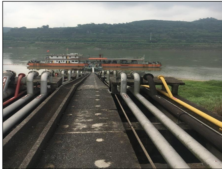
图 2-3 码头至罐区管线
