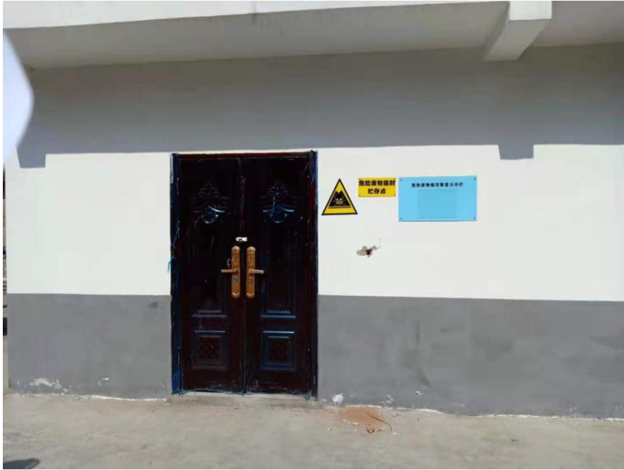
图 3-7 新建的危废暂存间（标识标牌、信息栏）
