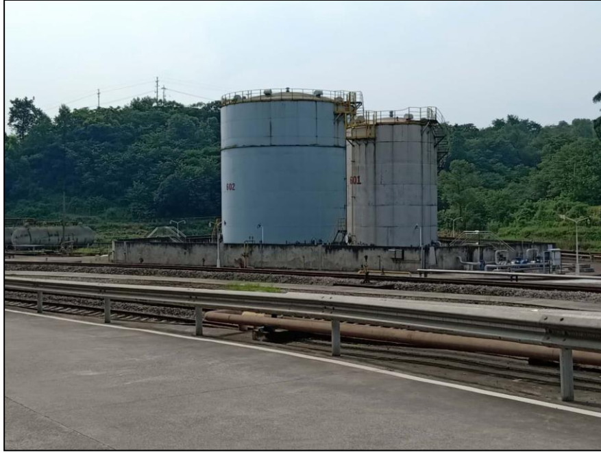
图 2-6 6#罐区 V601、V602 储罐
