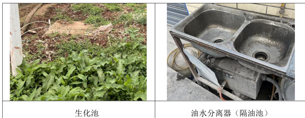
图 3-2 废水治理设施流程以及监测点
