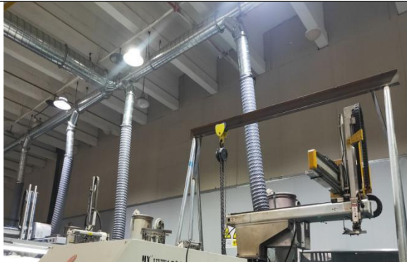
注塑废气收集管道
