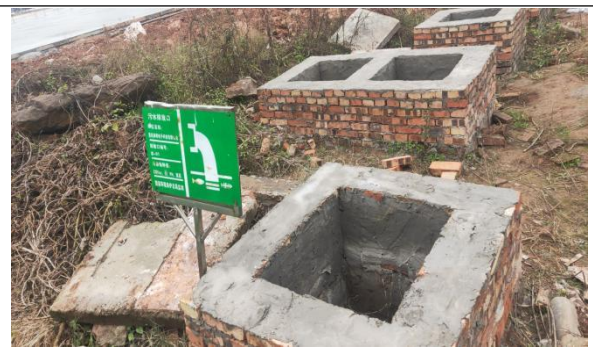
项目依托的生化池
