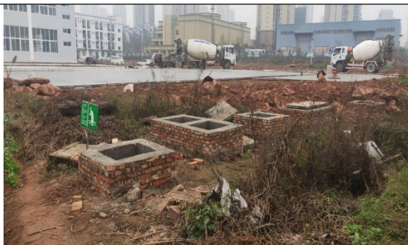
项目依托的生化池
