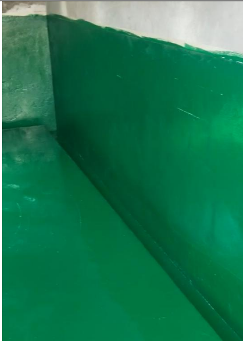
危废间已做防腐防渗
