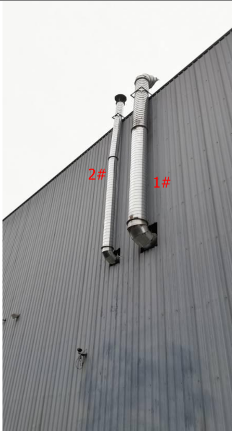
1#（喷涂废气）、2#（固化废气）排气筒
