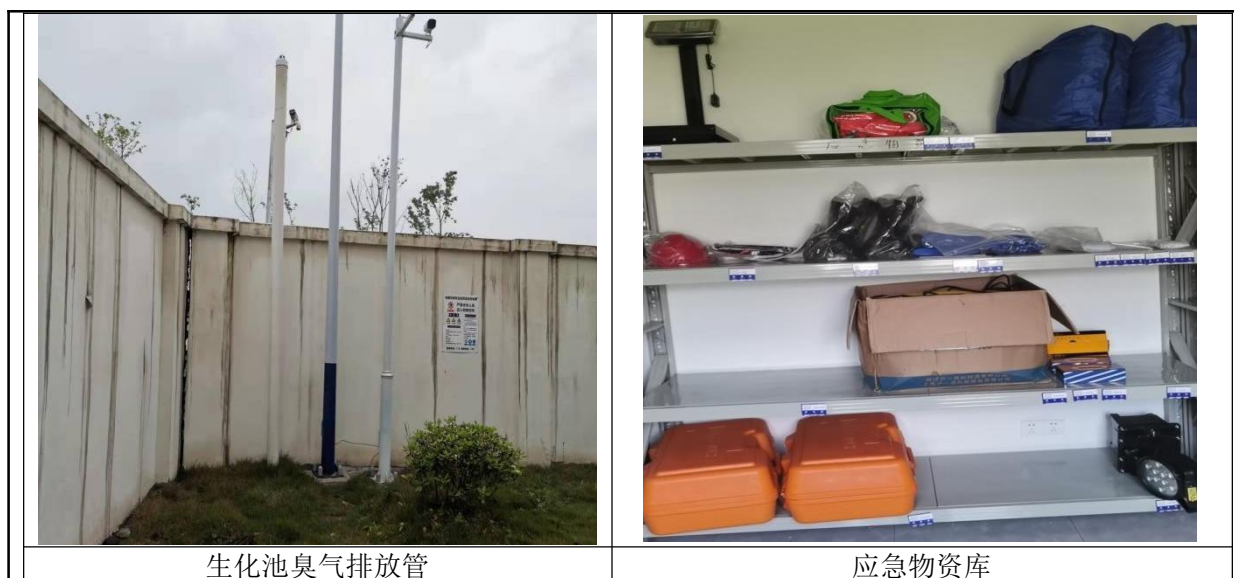
图 3-1 项目采取的污染防治措施
