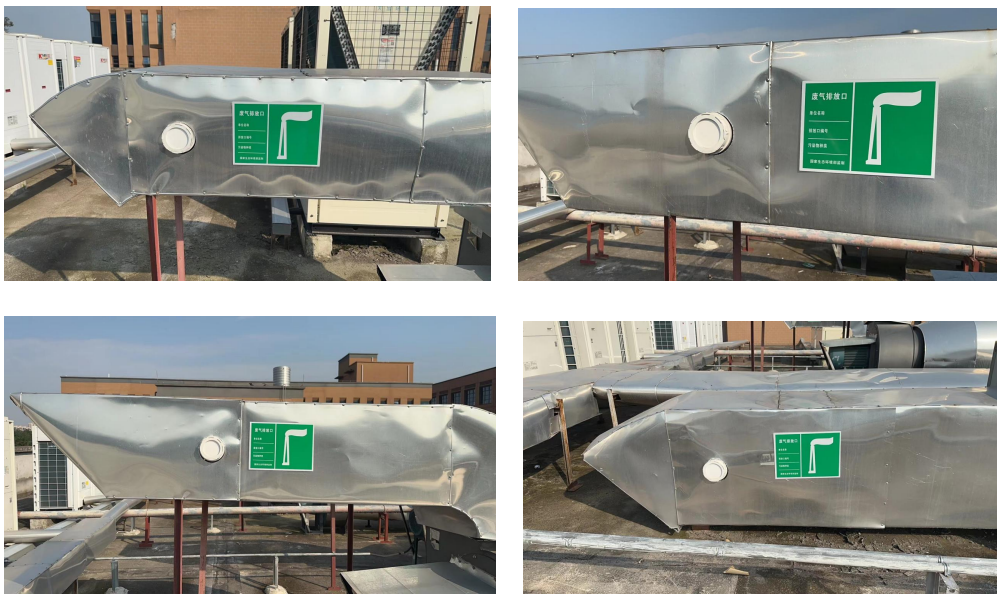
图3 废气处理设施整改后照片
