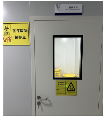
图2 危废暂存间整改后照片
